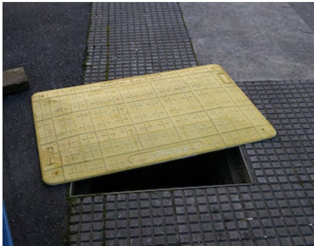
Imatge 2. Mostra de col·locació de planxa de fibra de vidre amb reforç de barres metàl·liques.
