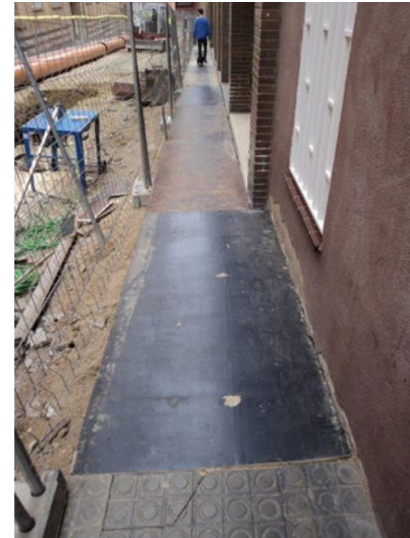
Imatge 1. Mostra de col·locació de planxa de protecció en rasa o pou.
