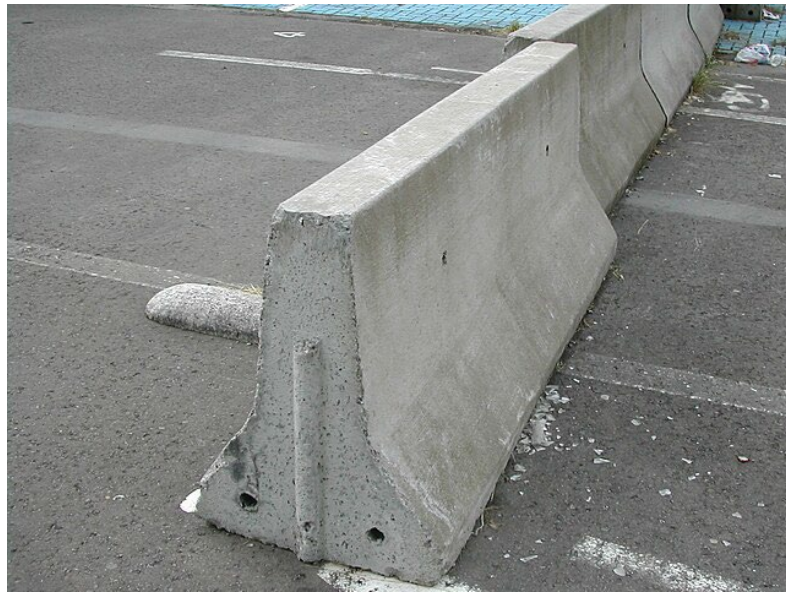
Imatge 5. Mostra de barrera doble New Jersey.
